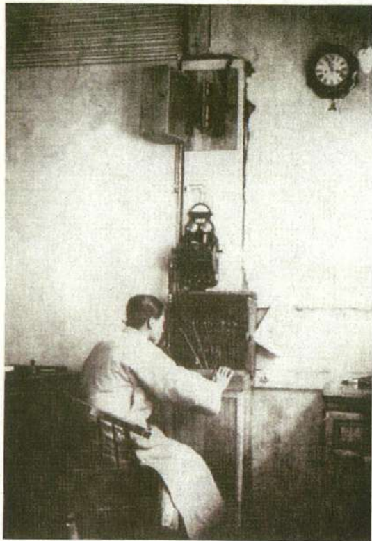
1931年、鄞県鄉村電話交換所の20回線交換機
