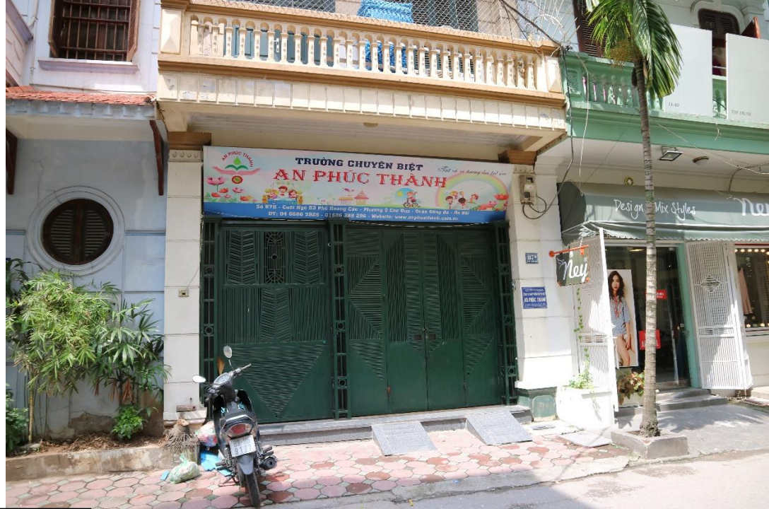
写真 3 3. センター外観
