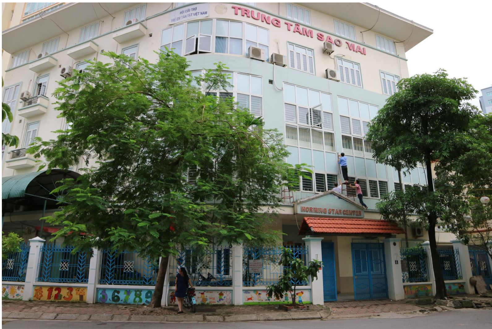
写真 2 2 . センター外観
