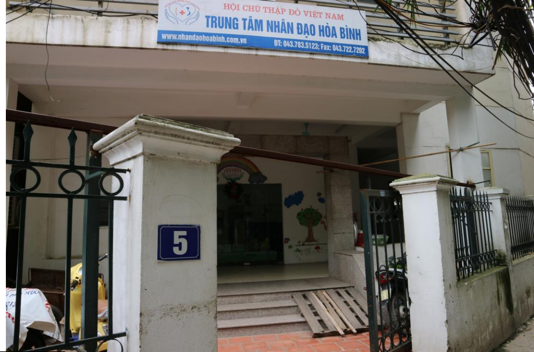
写真30. センター外観
