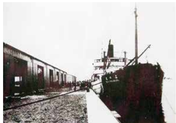
写真7 丙岸壁に着岸した「泰仁丸」（初の接岸荷役）
